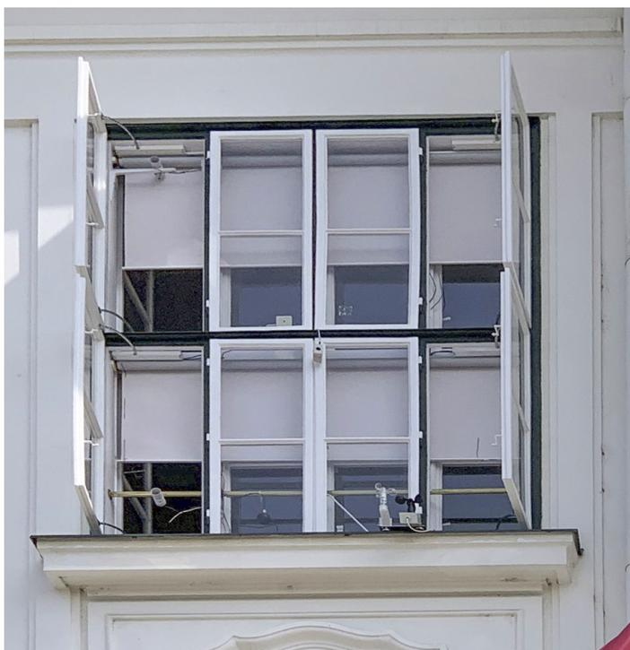
Abbildung 5: Testbüro an Südfassade des Altbaus der Universität für Weiterbildung Krems: Zustand kurz vor morgendlicher Schließung des Fensters und Aktivierung der beiden Verschattungsrollos, Foto ©: Markus Winkler
