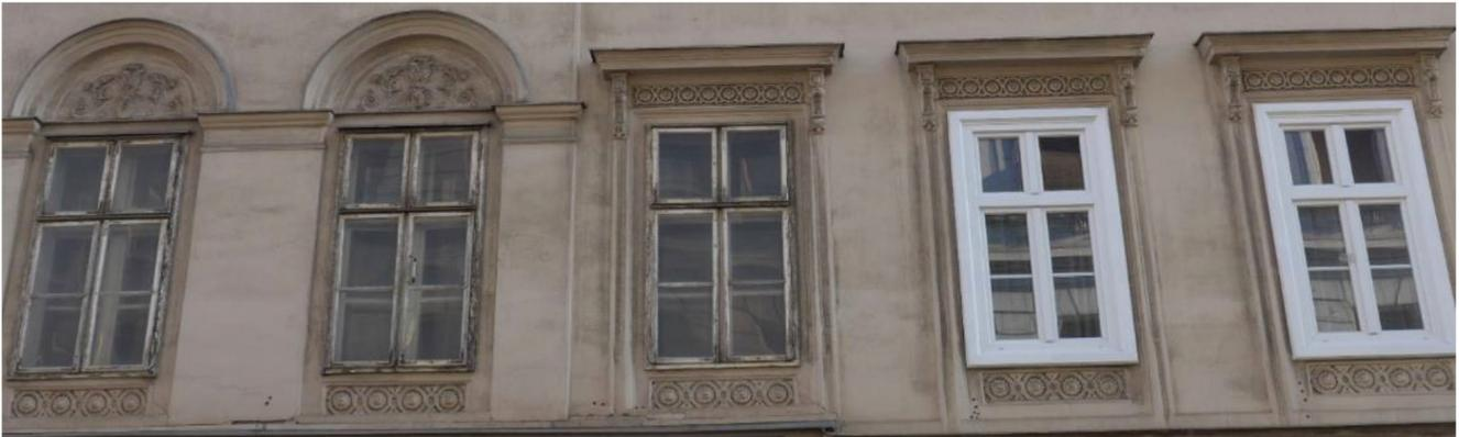
Abbildung 01: Uneinheitliches Fassadenbild: Während die offenbar noch halbwegs originalgetreuen, sehr zarten Kastenfensterkonstruktionen bei den drei Fenstern links einer Instandsetzung sehnsuchtsvoll entgegen harren, sind bei den beiden Fenstern rechts wenig passende, viel klobigere Fenster im Zuge eines Fenstertausches eingesetzt worden (Quelle: P. Schober / HFA).
